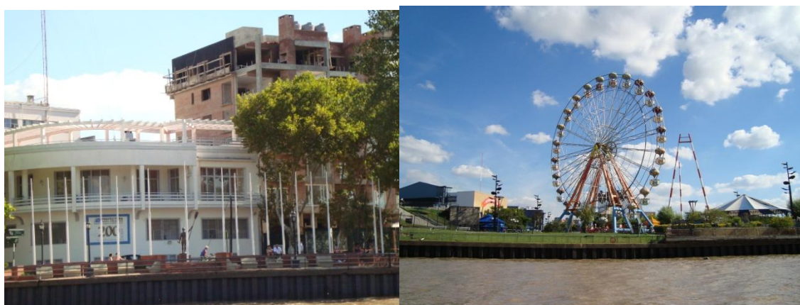
Foto 21: Tigre, Prefectura Zona Delta y nueva construcción sobre Paseo Victorica. / Foto 22: Tigre, Parque de la Costa a orillas del río. © IIED-AL (2-03-12)
