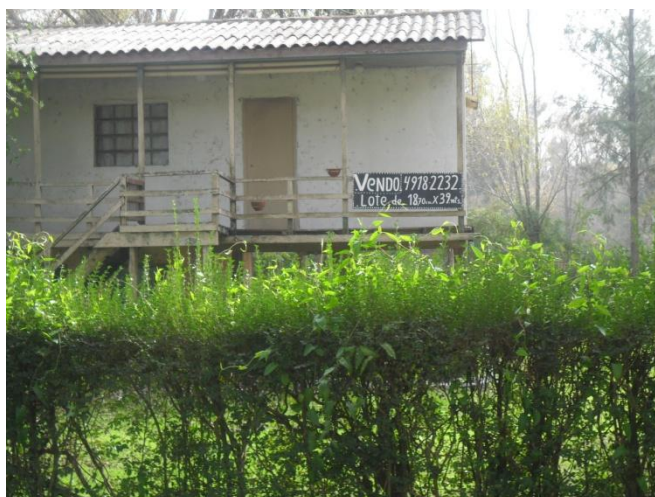
Foto 27: Tigre, vivienda elevada sobre pilotes (calle La Beatriz), Villa La Ñata. © IIED-AL (14-06-12)
