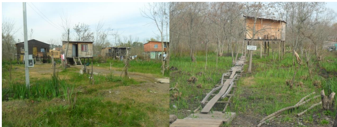
Fotos 25 y 26: Tigre, viviendas de madera construidas sobre pilotes, Barrio Rialto, Dique Luján. © IIED-AL (14-06-12)
